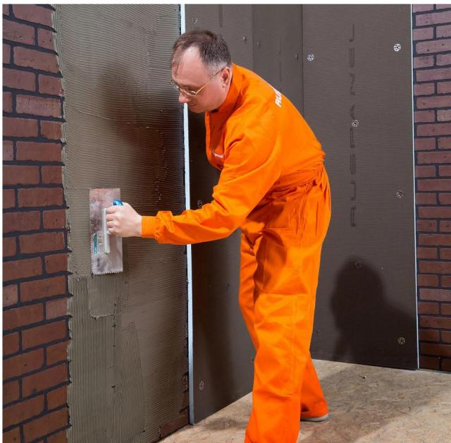
**В случае необходимости выравнивания основания** панели закрепляются на клей КР, наносимый зубчатым шпателем на плоскость стены или пола, затем панель дополнительно фиксируется с помощью дюбелей через расширительную шайбу **РУСПАНЕЛЬ** из расчета 11 шайб на 1 панель.
